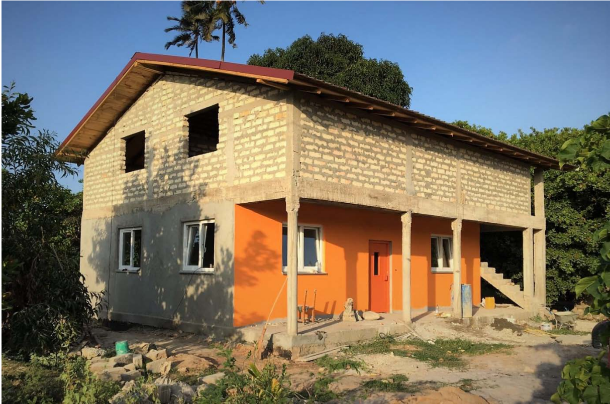
Der Rohbau des „Doctorhouse“
